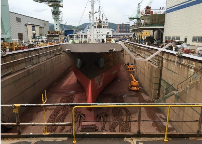
■ 2号ドック (1600G/T 渠底長:L85.5m×W17.0m)
