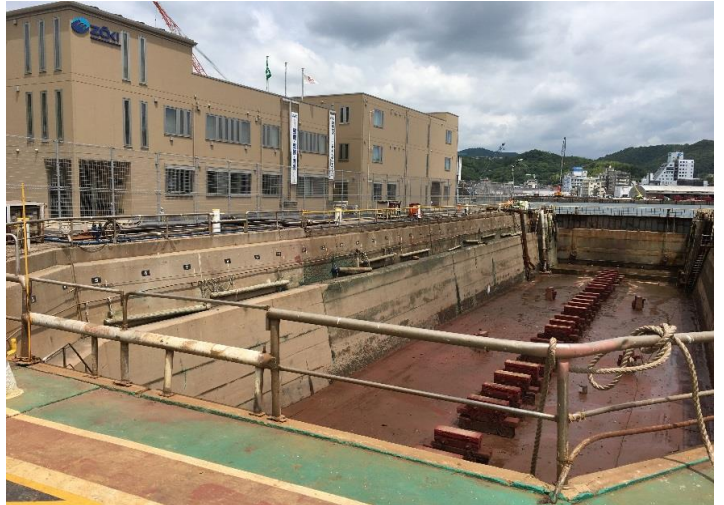
■ 1号ドック (700G/T 渠底長:L68.76m×W12.5m)
