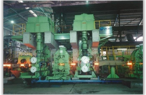
粗V-H圧延設備
